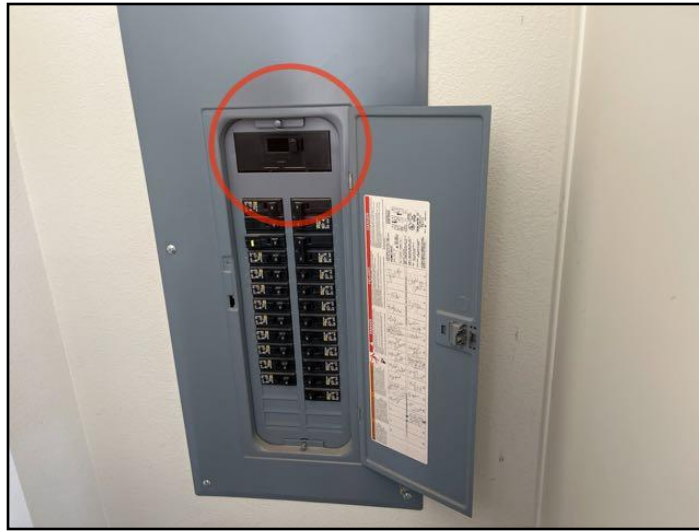
27. Breakers - garage/main shut off
